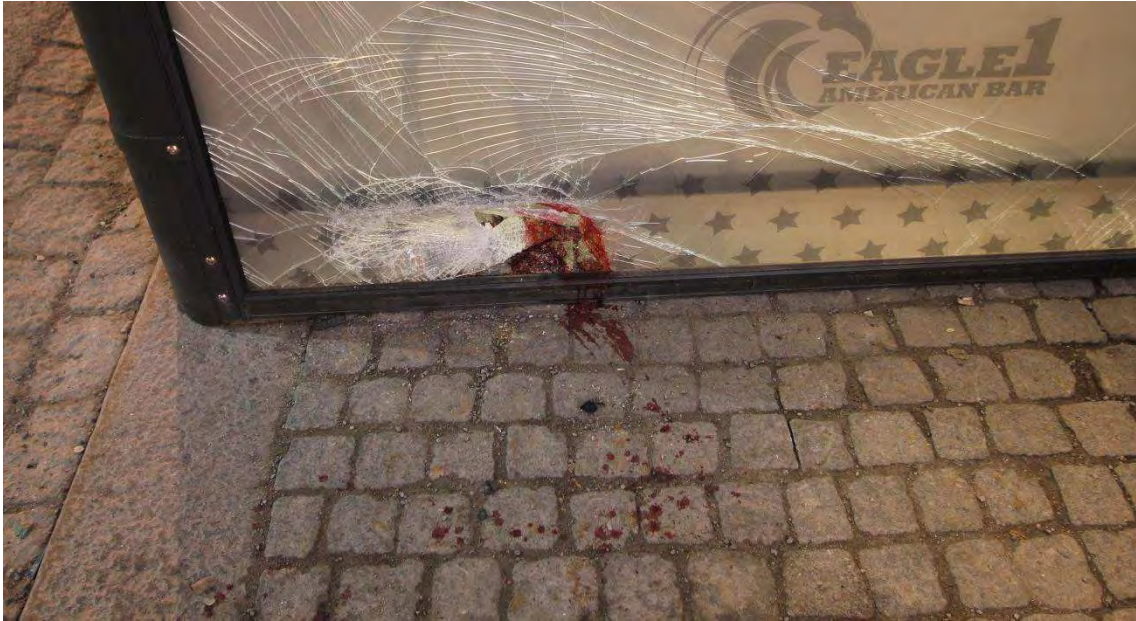
”Figur 6. Bild på skadan i staketet på uteserveringen”
