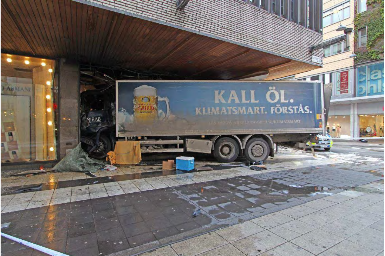
”Bild 6: Lastbilens placering i byggnaden där hytten är inkörd i en byggnadspelare och i varuhusets parfymavdelning.”
